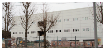
▶ 헤브론선교대학 신축건물 전경
